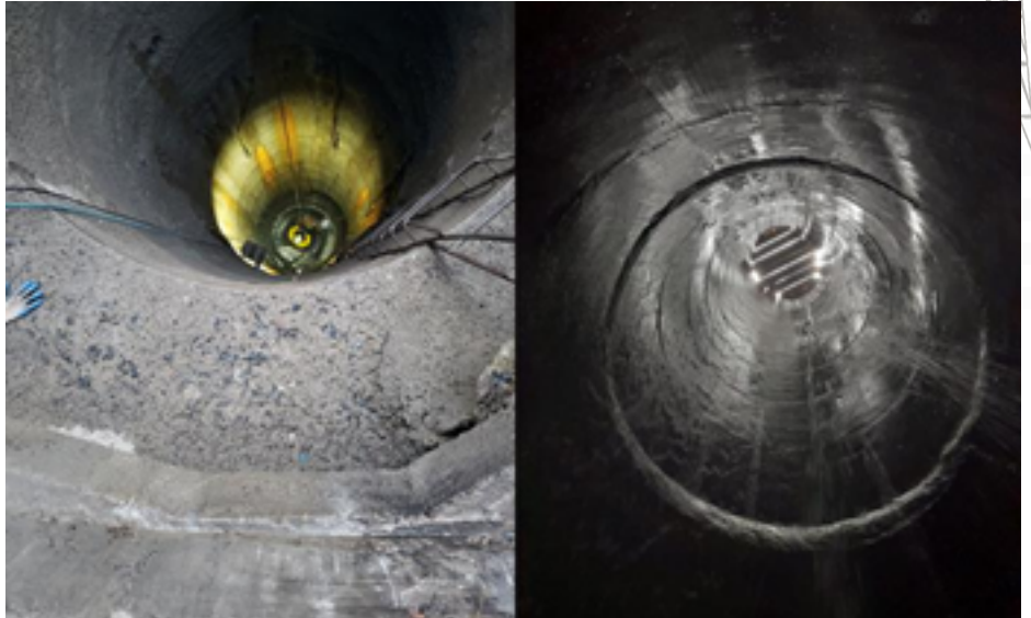
Finalización de Trabajos de revestimiento en el Pique Solitario
