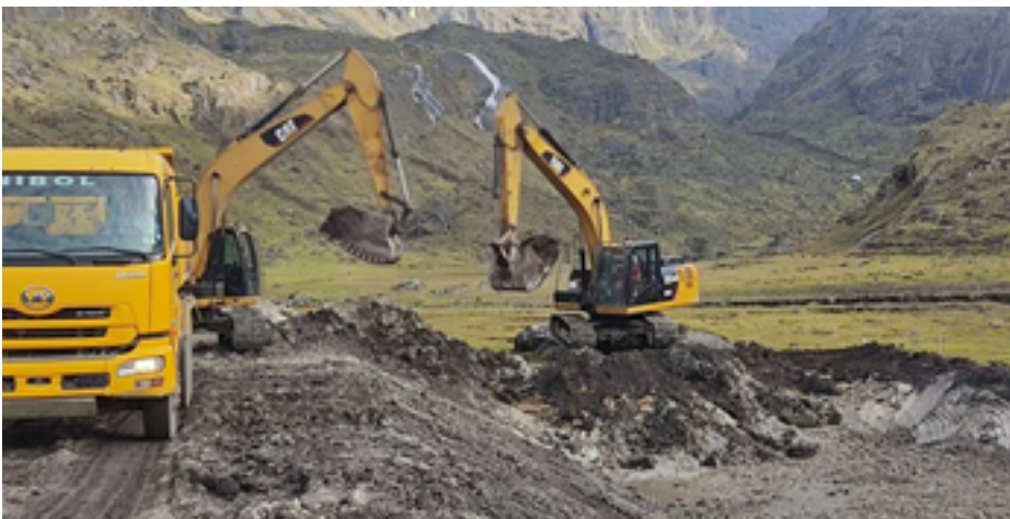
Presa Calachaka Jahuira, Excavación del canal temporal de desvío
